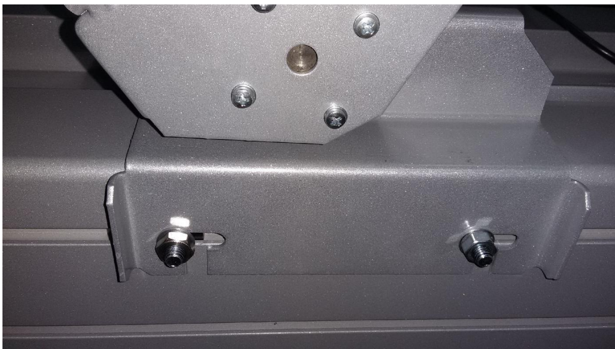
Рис. 5б. Установка кронштейна на стойку.
