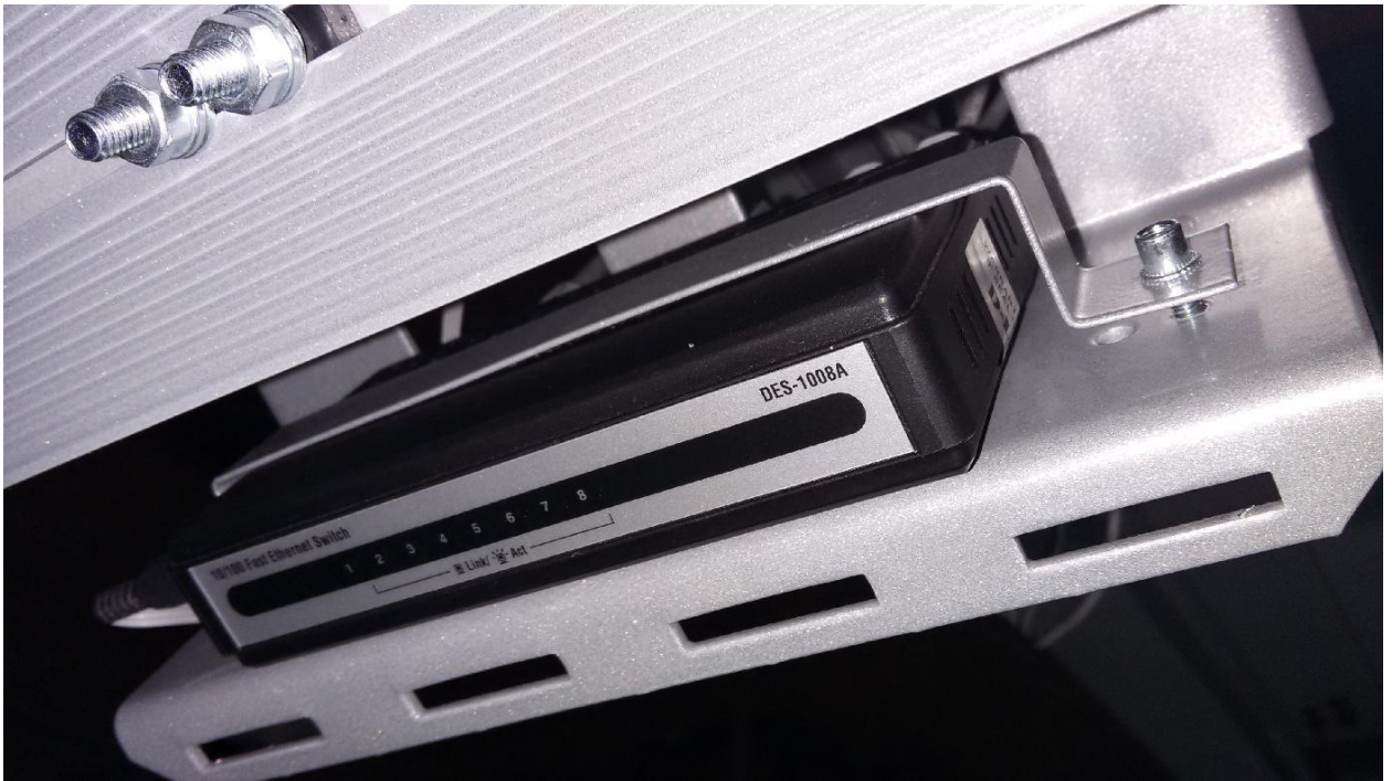
Рис. 5д. Установка хаба на кронштейн.
